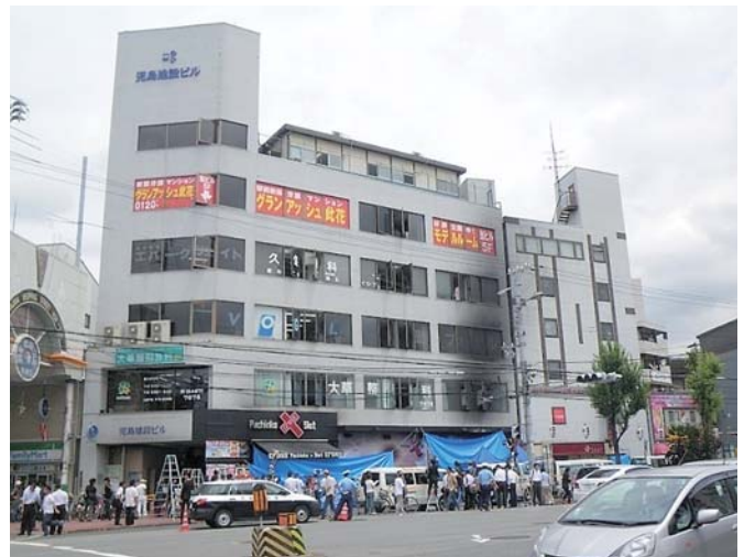
火災建物の外観
